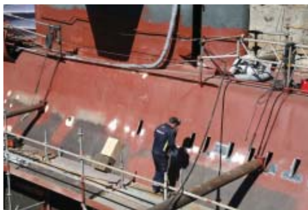
Förbättringsarbeten på ubåtens skrov
